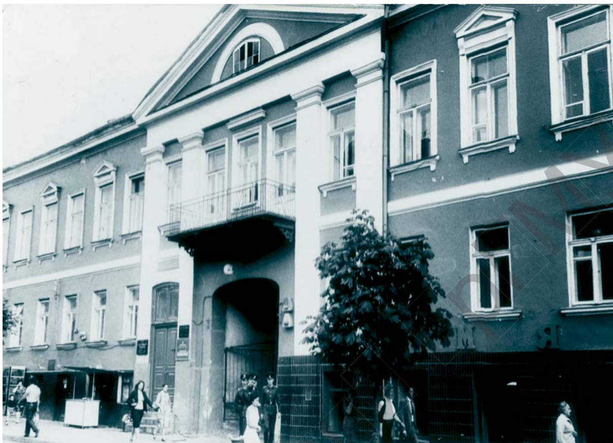
Главный корпус института, ул. Э.Ожешко,1 (1958-1974 гг.)
