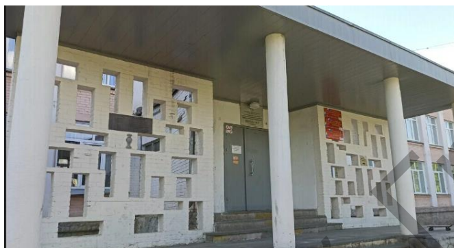
Фото 1. – Главный вход в школу
